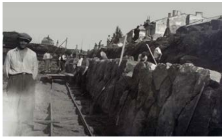
Рис. 9. Будівництво та укріплення кам'яною кладкою берега Ужа в районі сучасної Київської набережної. 1933–1934 рр. (Literati 2022b)
